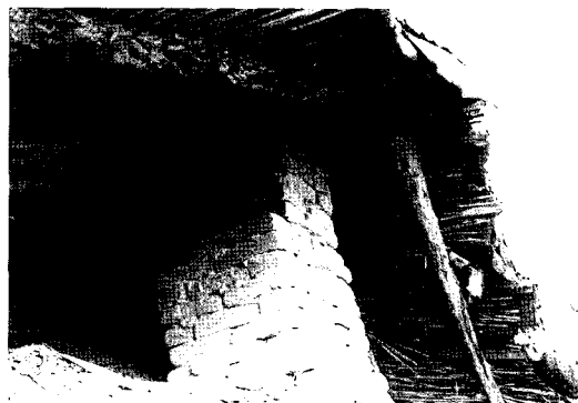
<그림 3> 깔을 재료로 한 지붕(타슈켄트, 아흐마드야사비 콜호즈)
