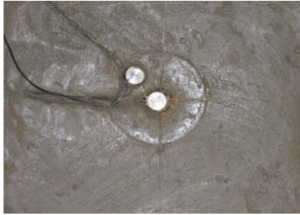
(a) 토압계의 설치
