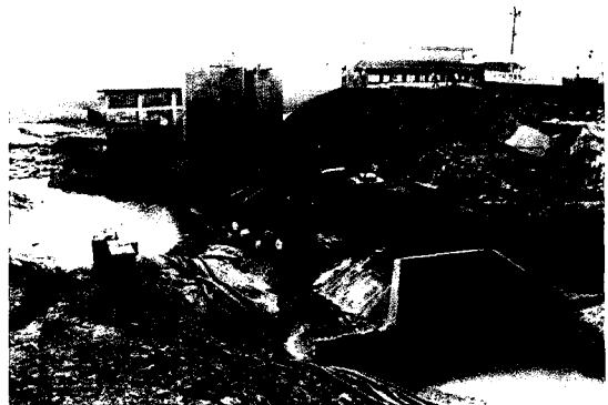
그림 1. 제방과 구조물 접합부 공동현상으로 인한 제방 붕괴(02.8)
