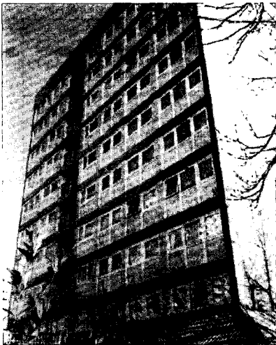
Fig. 7 PC의 건축분야 실적 예. (고층 아파트의 창문 아래 부분이 PC 판넬)
