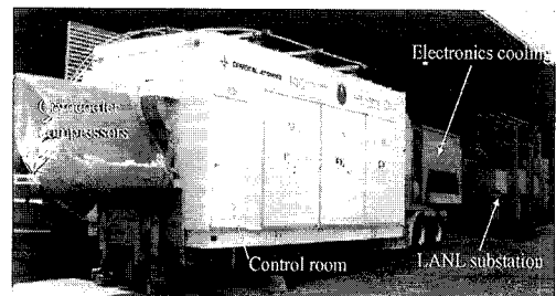
그림 6. 미국 GA와 LANL에서 개발한 12.5 kV / 2 kA급의 DC reactor형 고온초전도 한류기.
