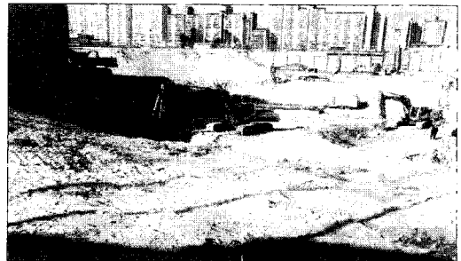
그림 12. 대상 작업장 전경
