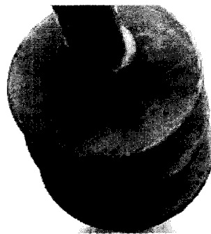
그림 2. 오손된 EPDM 고분자애자. Fig. 2. Polluted EPDM Polymer Insulator.
