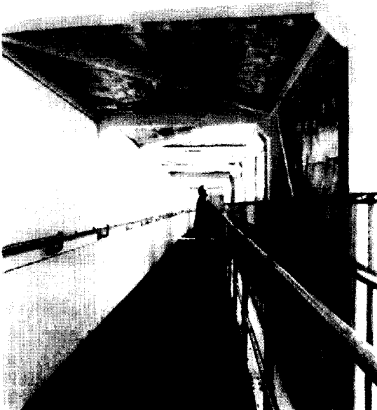
Fig. 7 FPSO대형채광선의 에스케이프 루트(터널 내부).
