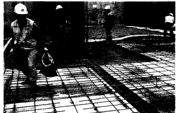
그림 9. Topping Concrete 타설
