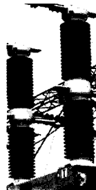
그림 1. 현수애자(suspension insulator)와 지지애자(support insulator).
