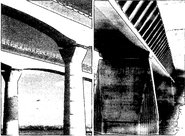
사진 3. Avignon viaduct 교의 지점부(프랑스)
