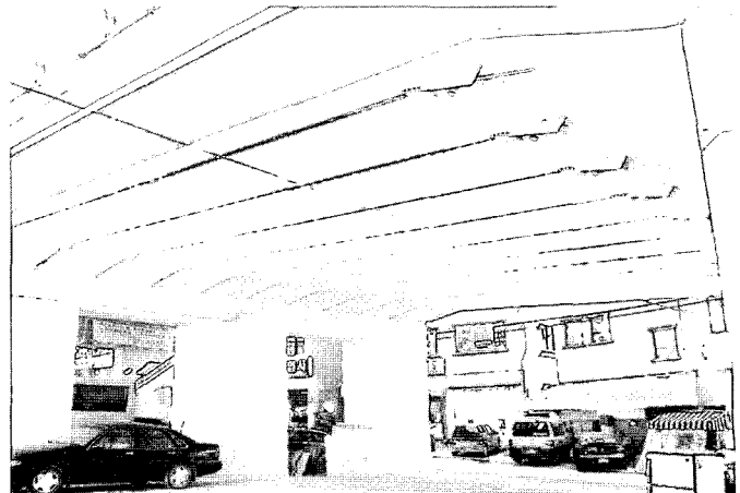
사진 8. 보강공사 후 전경
