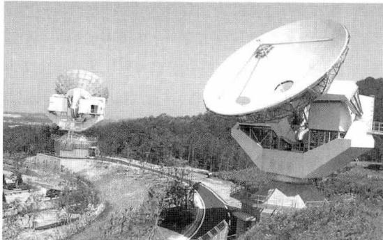
위성전파감시센터에서는 위성전파측정·분석시스템과 지름 13m의 위성자동추적 안테나 2기 등 최첨단 장비를 갖추고 있어 동경 55도와 서경 160도 사이의 적도 상공, 지형적으로는 인도양 빅토리아섬에서 태평양 하와이섬까지의 정지궤도 위성을 감시하고 있다. 또 주파수대는 L, S, C, X, Ku, Ka등 6개 대역으로 1.45GHz부터 21.2GHz사이에
