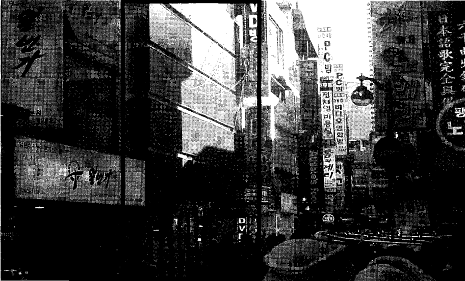
〈사진 8〉 명동 주변과 어울려 설치된 배전 Station 외관(사진 중앙부)
