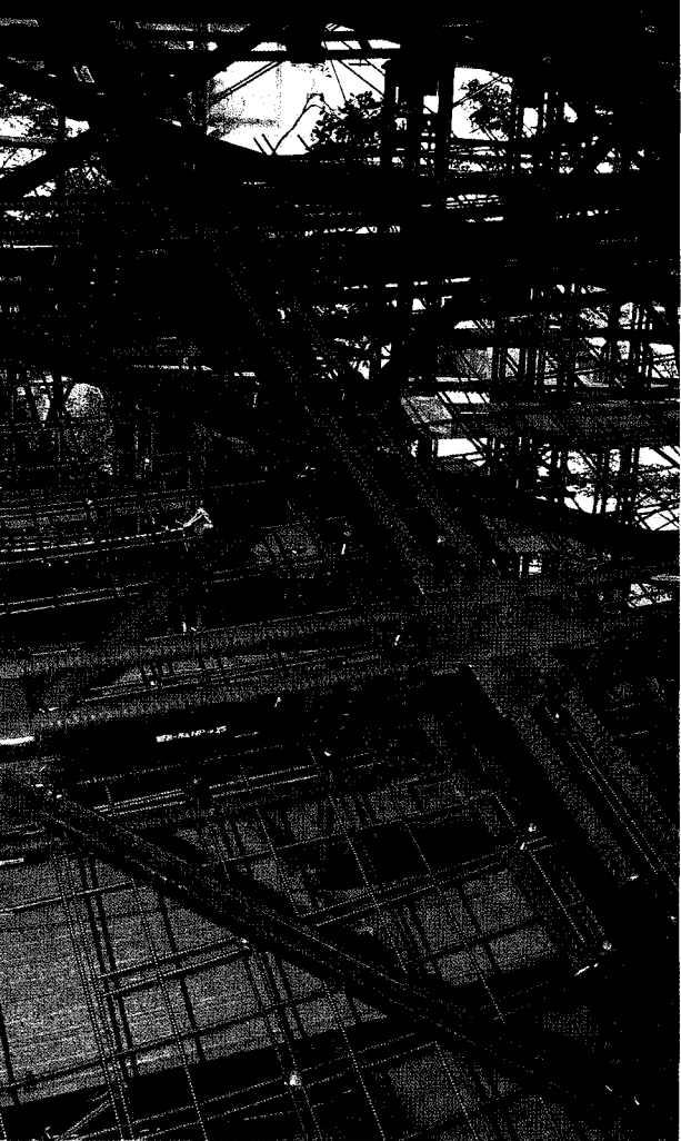
교차하는 장단 2방향의 부재중 단면방향의 프레임을 선행하였다. 단면방향은 상하의 철근을 포함하여 공장에서 가공하고 있다. 장면방향은 상부의 철근 민을 현장에서 설치하여 단면부재와 접하였다.
