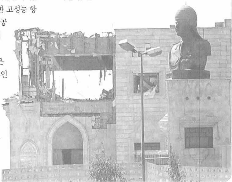
바그다드 대공습 후 폐허가 된 후세인 대통령궁
