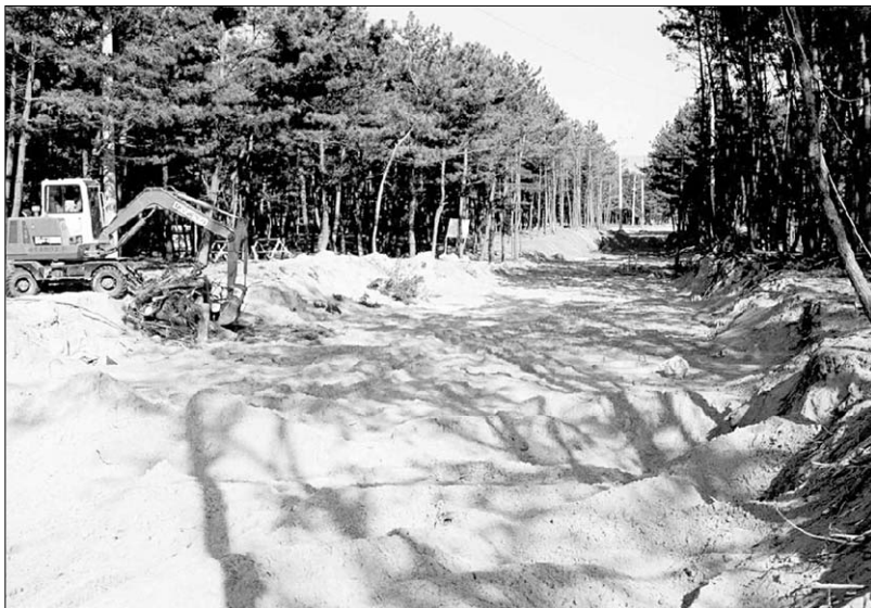
그림 4. 해안관광도로의 건설. 안면도 국제꽃박람회장으로 통하는 관광도로가 해안사구를 따라 건설되고 있다. 도로 건설은 불가피하게 해안사구와 산림의 훼손을 수반한다.
