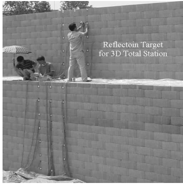
그림 6. 반사타겟 설치
