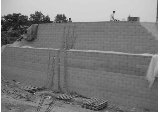
그림 9. 시공 완료 후 전경
