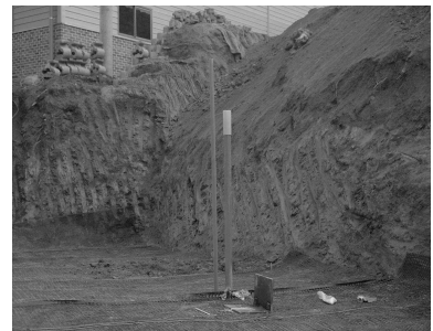
(c) 경사계 설치
