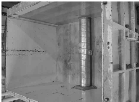
(a) 파형강관 설치 모습
