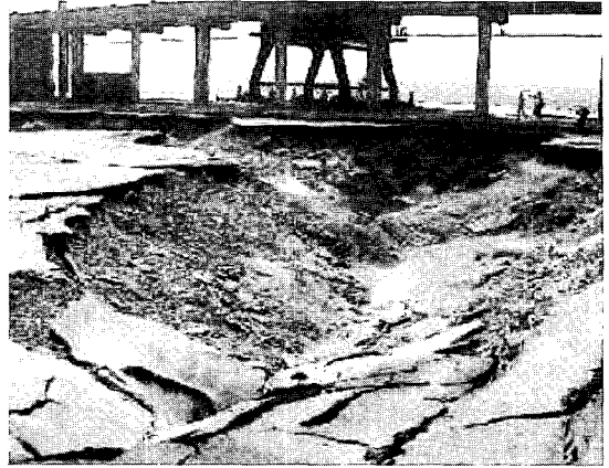
그림 26. 액상화에 의한 지반침하
