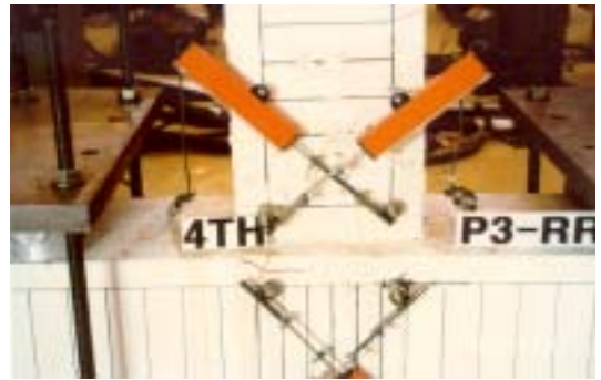
Fig. 5 P3-RR 시험체의 균열
