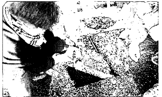
그림 7. 알루미늄판을 이용한 블록아웃 제거
