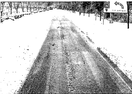
그림 6. Road Condition after Sand Deicing Asphalt Test-Pavement
