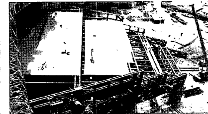
사진 12. 지붕 데크 설치
