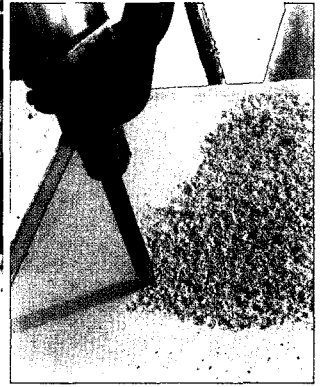
▲ 사진 20. 전동 장비로 쪼아 내는 모습
