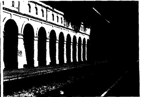
사진 6. 런던의 지하철 옹벽
