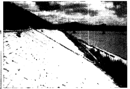
사진 1. 일반 콘크리트 블록에 의한 하천호안
