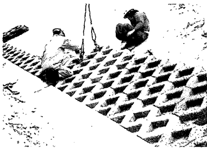
(b) 녹화 콘크리트 블록을 활용한 하천호안
