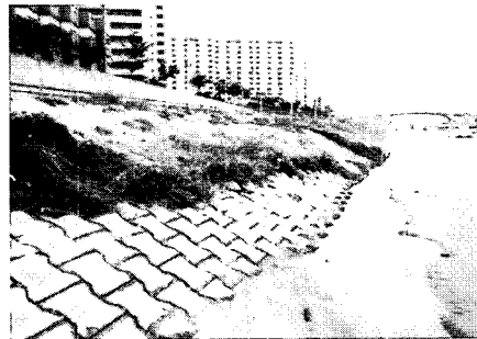
사진 1. 일반 콘크리트 블록에 의한 하천호안
