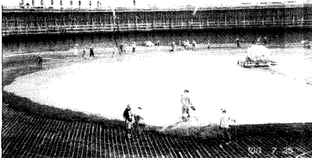
그림 8. 바닥슬래브 콘크리트 타설
