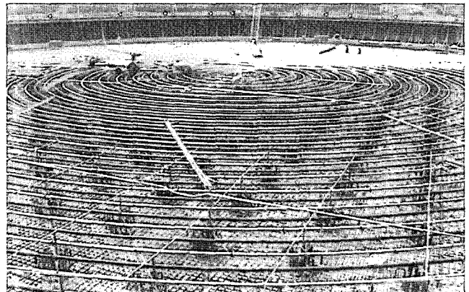
그림 7. 바닥슬래브 가열 파이프 설치
