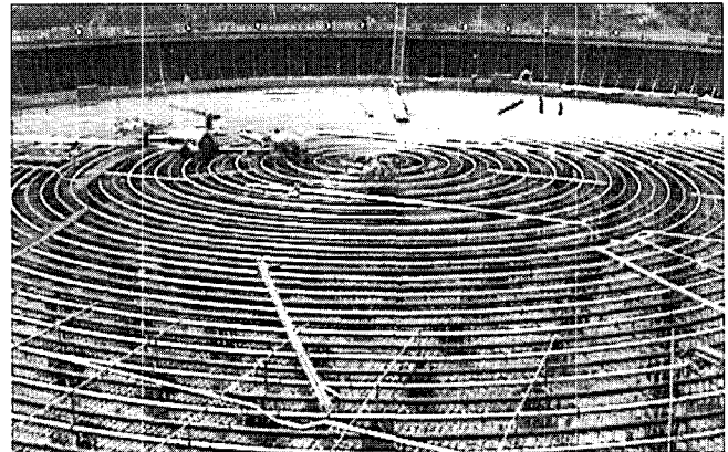
그림 7. 저부 가열식 탱크의 가열시스템
