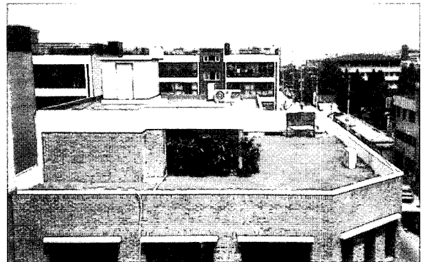
사진 2 식재용 포러스 콘크리트를 이용한 건물옥상녹화
