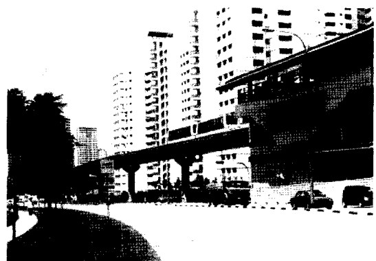
중앙 안내방식으로 운행되는 싱가포르 Bukit-Panjang Line (방음벽이 없는대신 주거지를 지날 때 차내에서 자동으로 차광장치가 작동됨)
