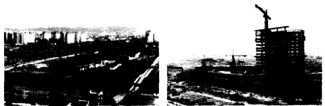
[철골공사 세우기시작 : 99.12월] [18층 CON'C 타설완료 : 2001.2월]
