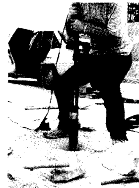
(c) 탐침 설치
