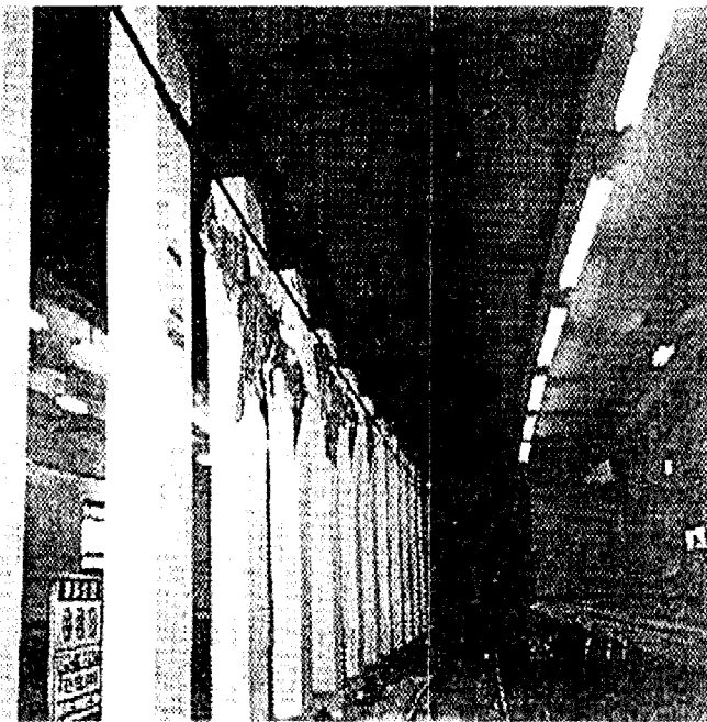
그림 8 예제와 유사한 지하철 정거장의 1995년 고베지진시 실제 파괴 양상
