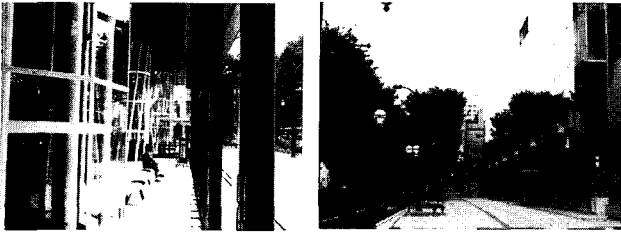
<그림 8> 내/외부 공간의 공간적영역을 상실한 1층 로비(내), 1층 현관(외)
