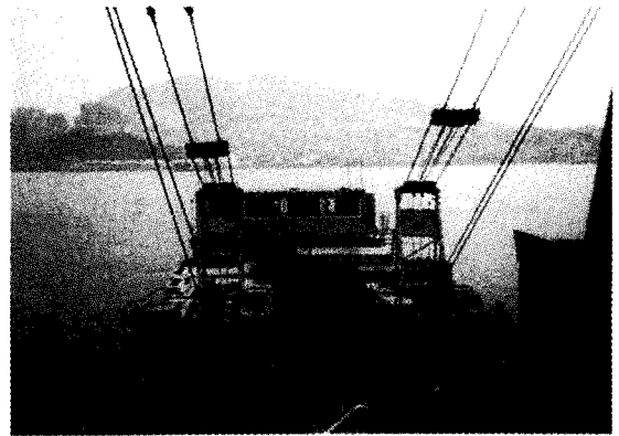
그림 7. 항타선의 이동국 안테나의 설치
