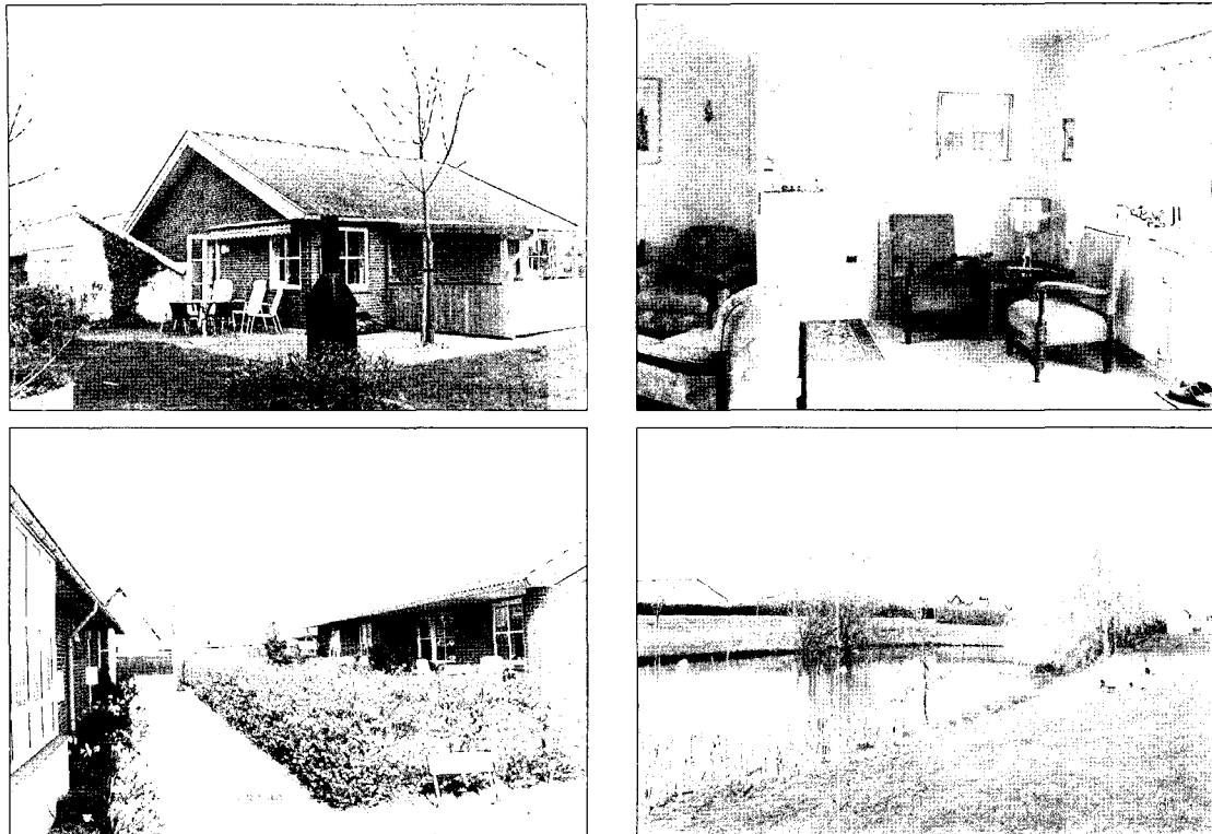
<그림 8> 아게드롭의 함머스파켄 노인용 코하우징 a) 공동생활실은 단층 건물로 뒷마당에 바비큐 오븐이 마련되어있다. b) 개인주택의 실내공간은 가변성 설계로 되어있어 거주자의 요구에 맞게 벽체를 가감할 수 있다. c) 개인주택은 단층 연립주택으로 앞, 뒤로 개인정원이 있고 독립된 창고를 가지고 있다. d) 단지 안에 있는 두 개의 연못에는 야생 오리들이 살고있어 평화로운 모습을 더해준다.
