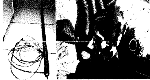
그림 12. 열선 케이블 설치
