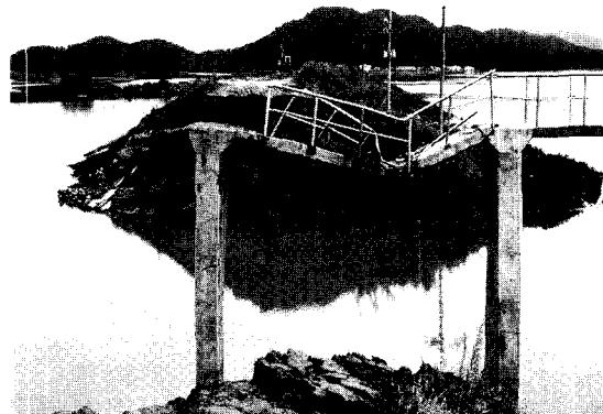
그림 10. 배수구조물에 의한 제방붕괴 (2002. 8 낙동강 백산제)
