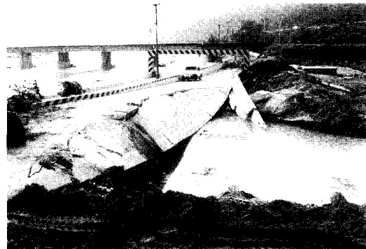
그림 8. 월류에 의한 제방붕괴(2002. 8. 직지사천)
