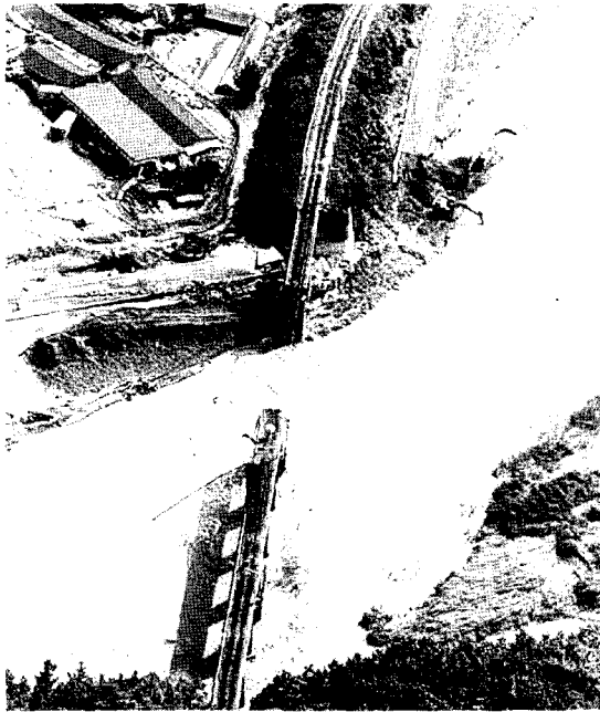
그림 1. 영동선 철교 유실
