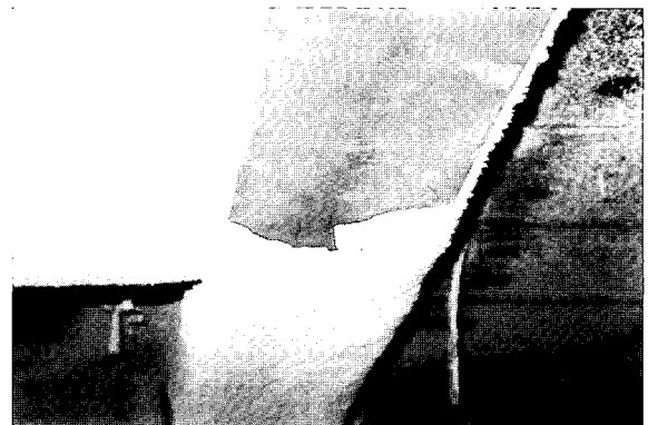
그림 1. 계면의 들뜸에 따른 내화피복재의 탈락
