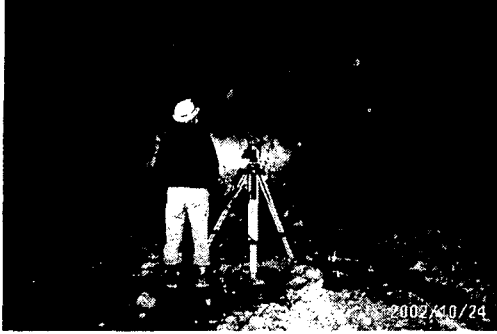
그림 4. Profiler를 이용한 여굴측량
