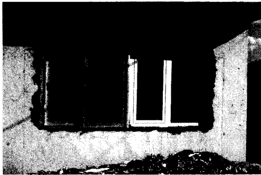
그림 1. 실험건물의 창문 설치현황.
