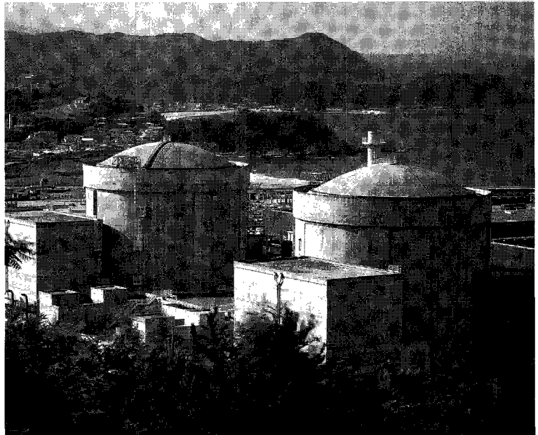
울진 1·2호기. 원전의 경우, 모든 계통·구조·부품(System, Structure, Components, SSC)은 교체가 가능하므로 안전성의 충족 여부는 그 비용이 과연 계속 운영을 타당하나 하는 것에 달려 있다.
