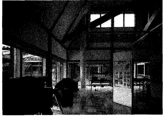
전시실의 내부. 천정 높이를 확보하기 위하여 경사진 보(登梁)를 채택하고 있다. 정면의 높은 창은 필요에 따라 차광을 하는 경우도 있다.
