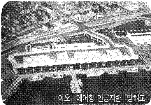
인공지반의 정비(북해도 아오나에(靑苗)어항)
