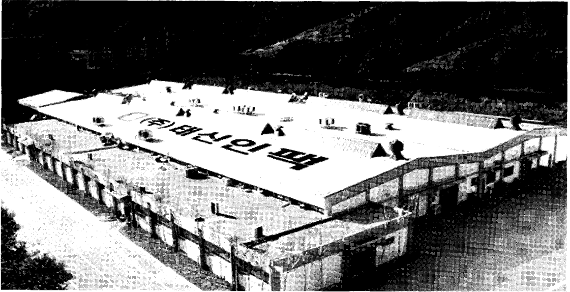
▲ 태신인팩(주) 청원공장 전경
