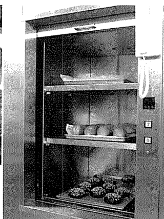
▲효모를 직접 배양해 제조하는 자연 발효빵 '팡 드 캄파뉴'. ▶2층 공장에서 1층 매장으로 제품을 손쉽게 운반할 수 있도록 설치된 덤웨어.
