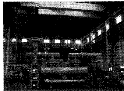
362kV 63kA 4000A 가스절연개폐장치
